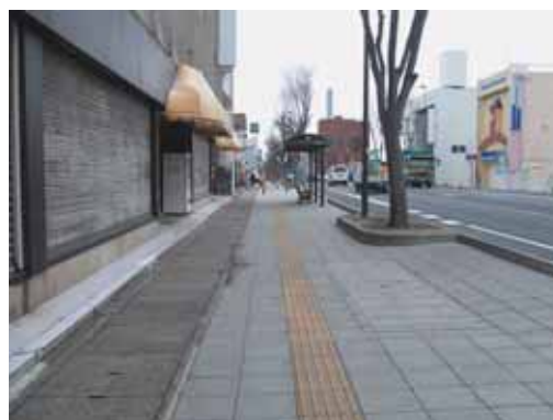
国道6号(山側:歩道)
