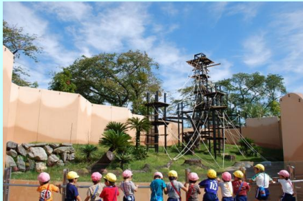
チンパンジー舎(獣舎等再整備整備事業)
