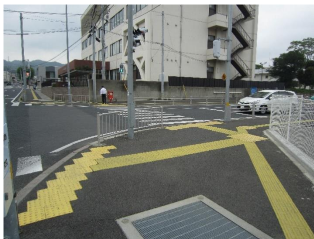
写真—安全に歩行できるよう設置された点字ブロック
