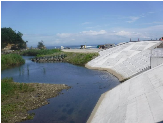
写真一 十王川護岸整備
