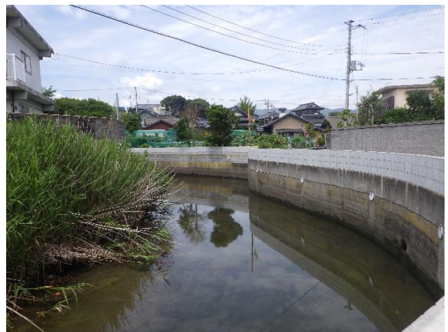
写真一 田尻川河川改修
