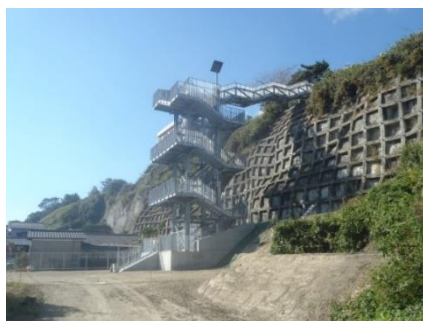
写真－津波避難階段（旭町地内）
