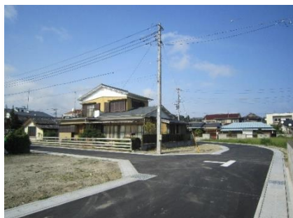
写真－狭あい解消・防災性向上のための道路整備
