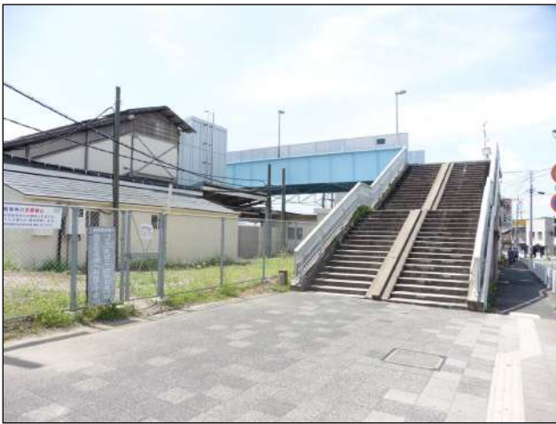
写真2-4-8 跨線人道橋（鉄道西側）
