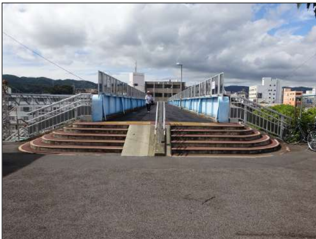
写真2-4-10 跨線人道橋（鉄道東側）
