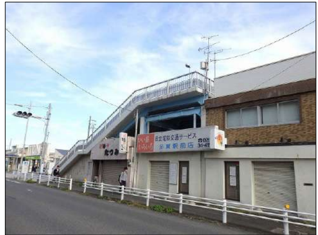
写真2-4-9 跨線人道橋下の店舗 (鉄道西側)
