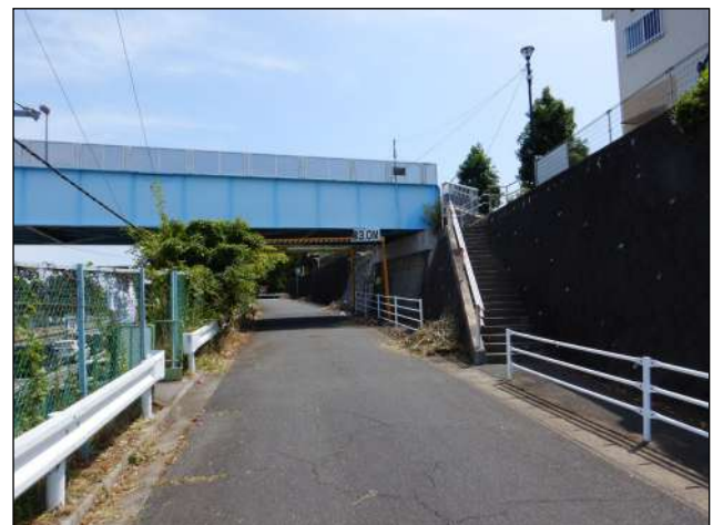
写真2-4-11 跨線人道橋と市道の交差部 (鉄道東側)
