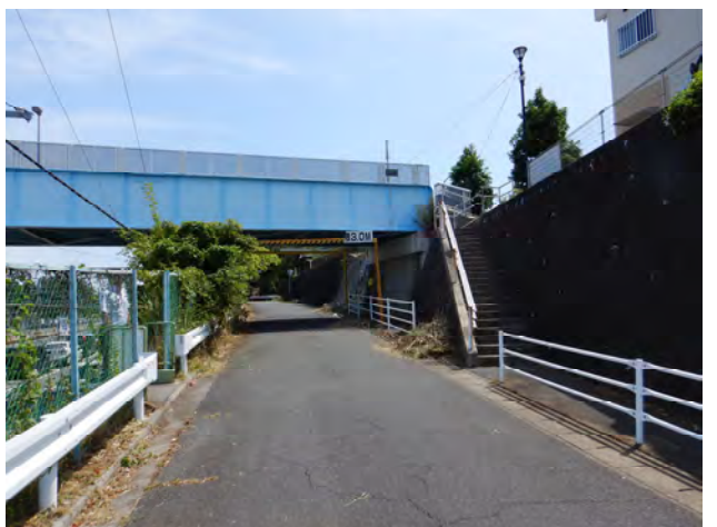
写真2-4-10 跨線人道橋と市道の交差部 （鉄道東側）
