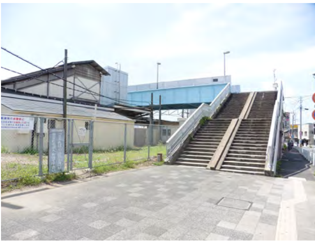
写真2-4-7 跨線人道橋（鉄道西側）
