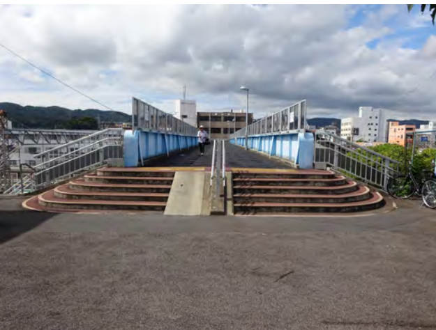
写真2-4-9 跨線人道橋（鉄道東側）
