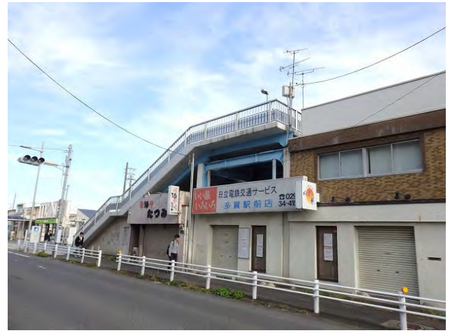
写真2-4-8 跨線人道橋下の店舗 （鉄道西側）
