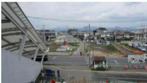
神立駅西口地区土地区画整理事業（施工中）
