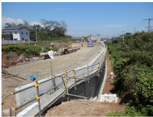
大甕北通り～大甕駅北こ線橋の擁壁工事
