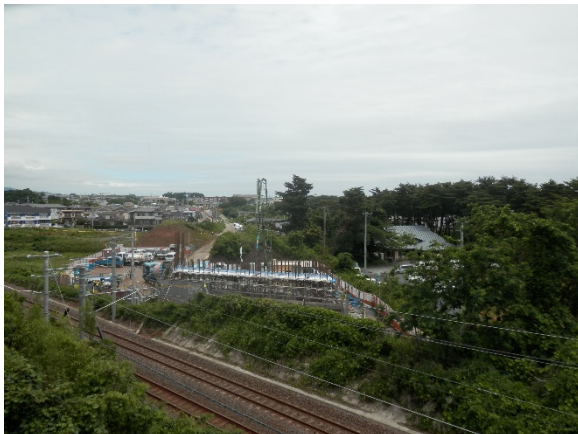
JR を跨ぐ橋梁工事 (下部工の構築)
