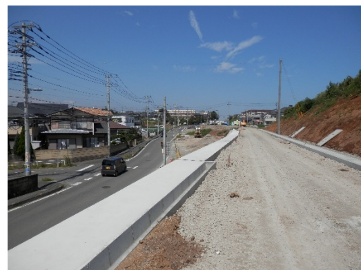
松山下団地～旧水木駅交差点の擁壁工事
