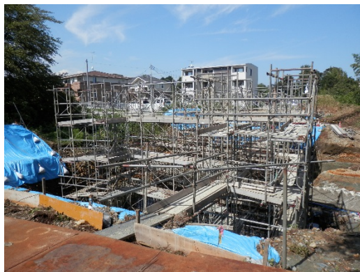
金沢川の橋梁架設(下部構築)工事
