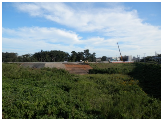
大甕北こ線橋架設ヤードの整備
