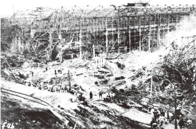
▲1トン爆弾で破壊された海岸工場電動機工場 1945(昭和20)年6月10日(日立製作所日立工場提供)
