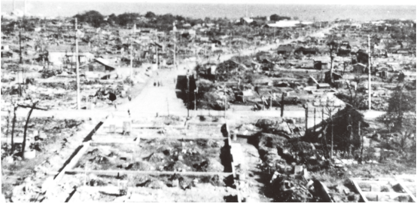
▲焼野原となった日立市街地 1945(昭和20)年(日立電線提供)
