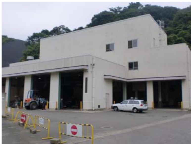
写真 3-2-2 粗大ごみ処理施設
